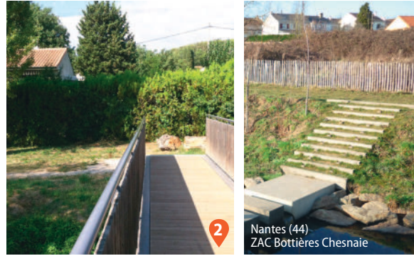
Aménagement a minima de la traversée du cours d'eau.
