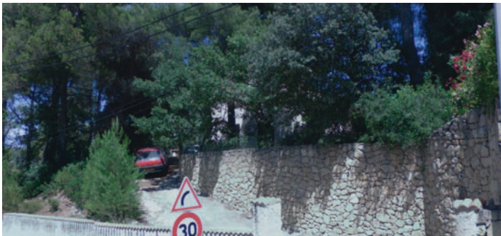
Mur de soutènement en pierre naturelle
