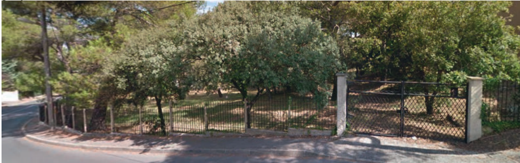
La clôture composée d'un muret très bas et d'une grille de facture simple suit la pente du terrain avec des redents réguliers et discrets
