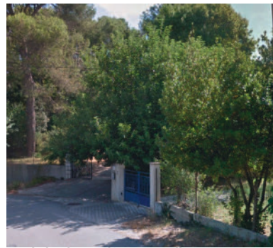
Mur bahut bas et clôture en grillage transparente
