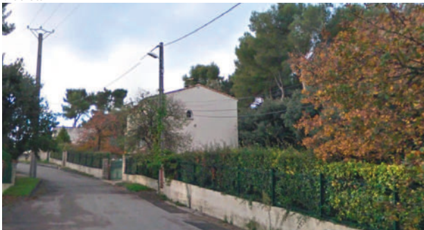
La clôture suit la pente du terrain de façon régulière sans redent
