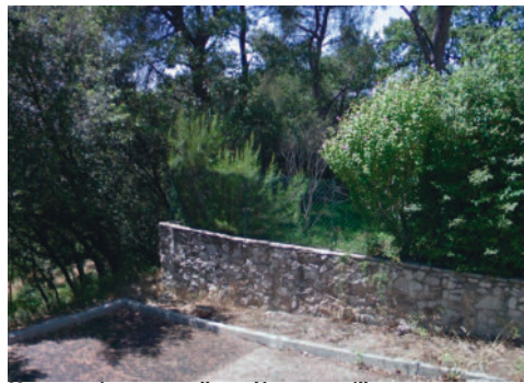
Muret en pierre naturelle et clôture en grillage transparente
