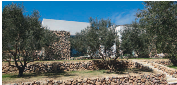
Aménagement du terrain en restanques
