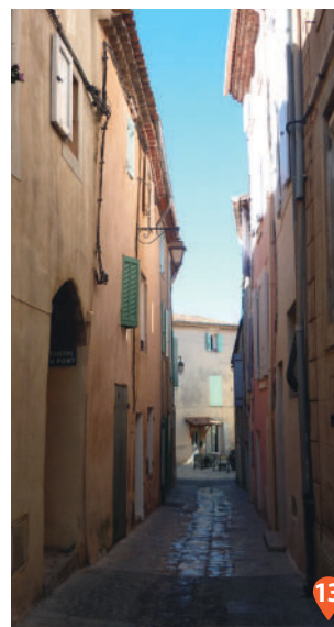
2 Les façades sobres, sans débord, orientent, cadrent le passant, ici vers la place de l'Horloge.
